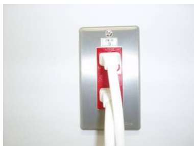
コンセントにご注目。こちらの赤いコンセント、なんと停電時に自動で 自家発電に切り替わるという優れたもの。
